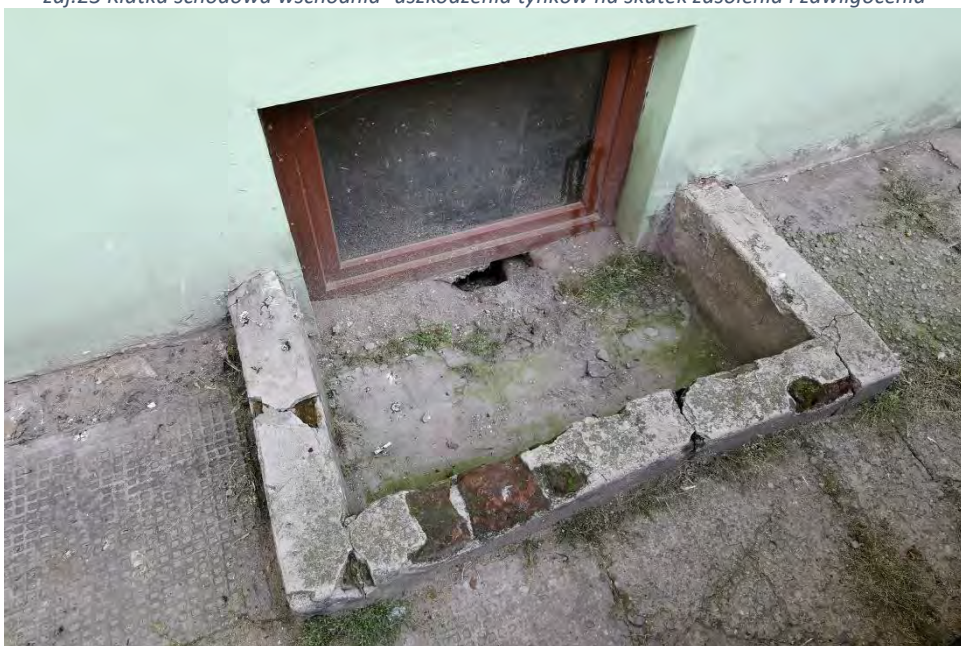
zdj.24 Studzienka okna piwnicznego, szczelne okno współczesne. Otwór pod oknem powodujący przecieki
