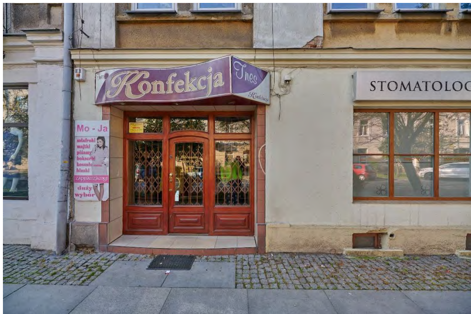
zdj.7 Zawilgocenia i uszkodzenia cokołu na elewacji północnej
