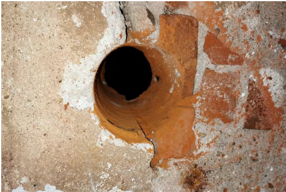
zdj.34 Wentylacja pośrednia między komórkami piwnicy
