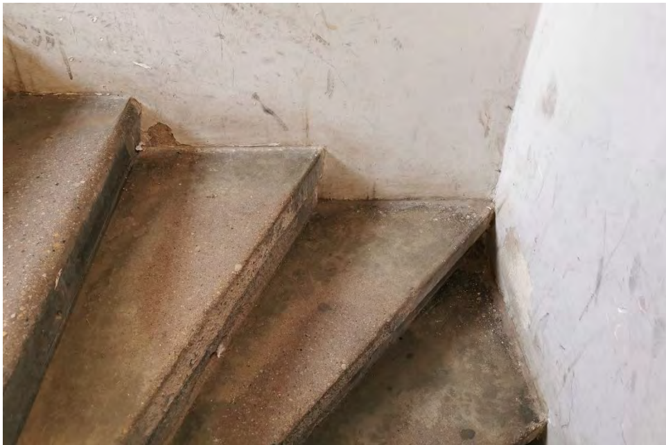
zdj.22 Klatka schodowa wschodnia- uszkodzenia tynków na skutek zasolenia i zawilgocenia.
