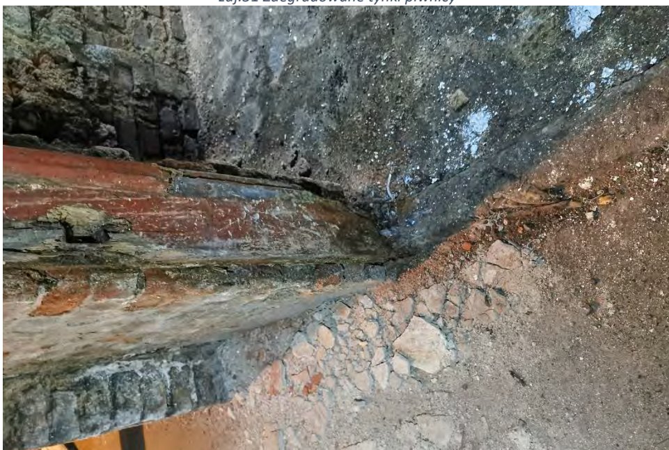
zdj.32 Korozja biologiczna stolarki drzwiowej
