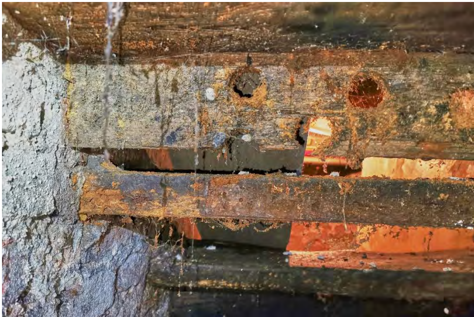
zdj.37 Porażone biologicznie i spożytkowane schody piwnicy
