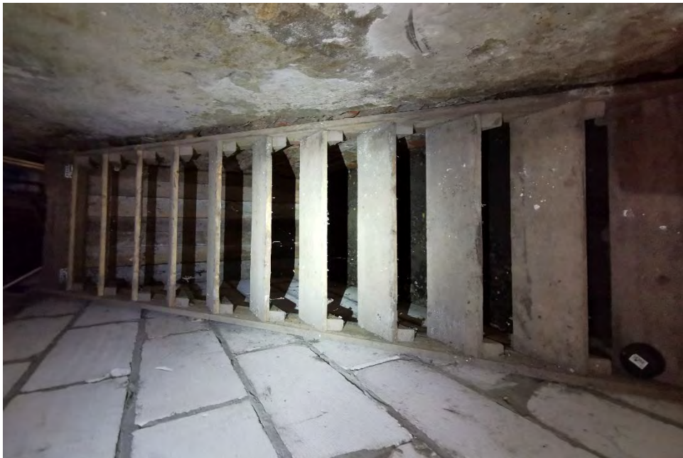
zdj.43 Schody o niewystarczającej nośności
