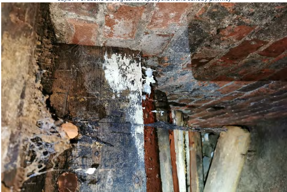
zdj.38 Grzybnia grzyba domowego na schodach
