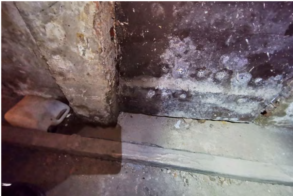
zdj.46 Korozja biologiczna stolarki drzwiowej piwnicy, wysolenia i degradacja tynków
