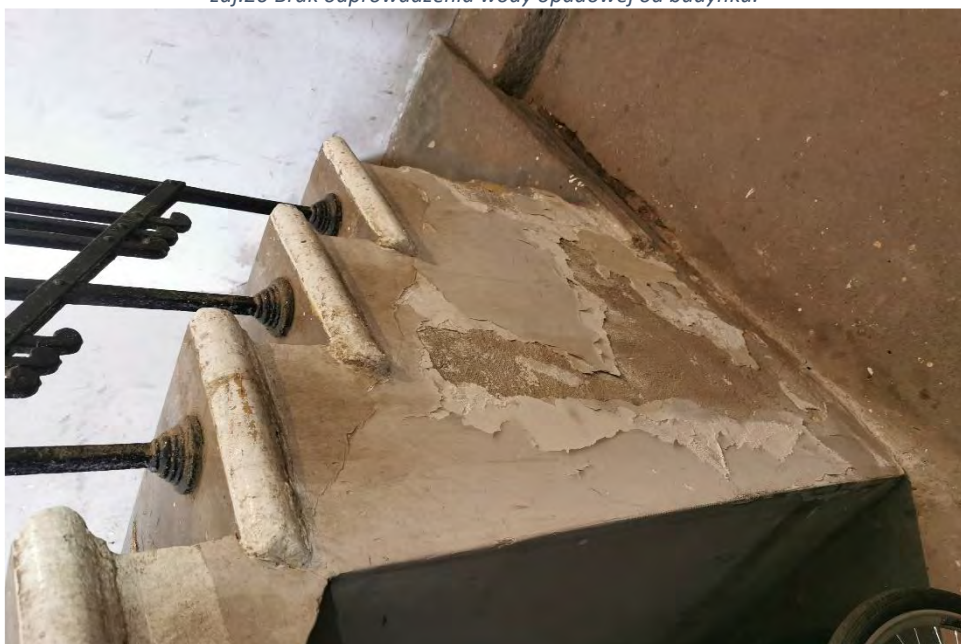
zdj.21 Klatka schodowa wschodnia, zawilgocenia i uszkodzenia tynków.
