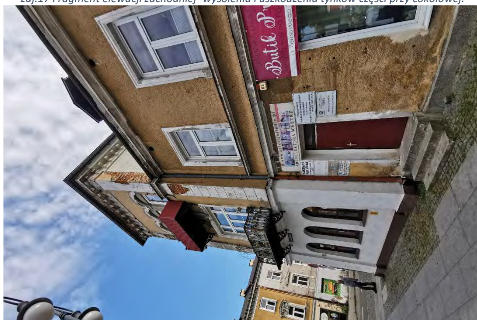
zdj.18 Elewacja zachodnia- uszkodzenia tynków części przy cokołowej
