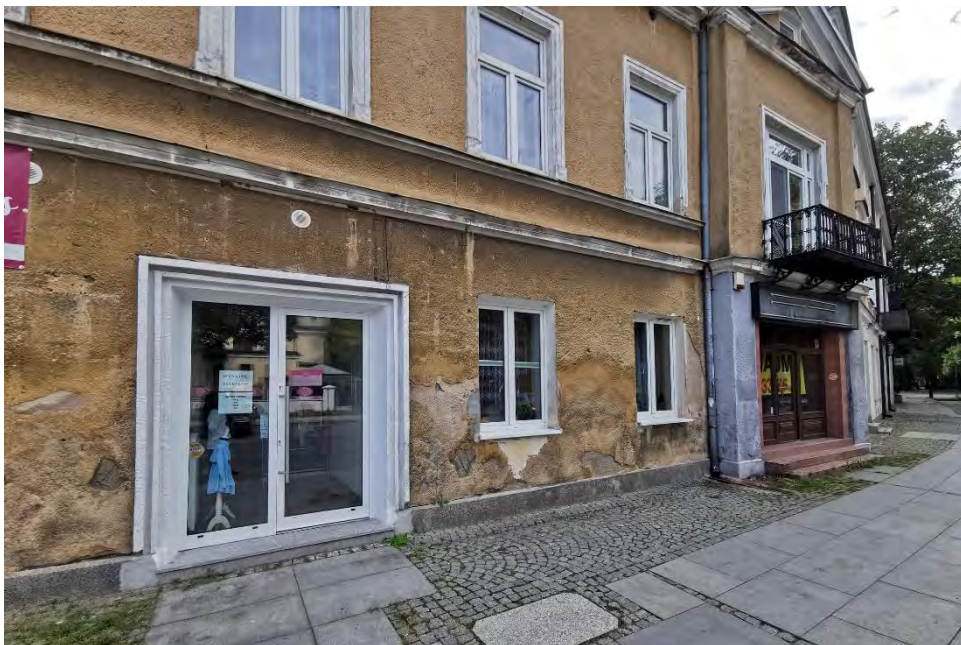
zdj.19 Elewacja zachodnia uszkodzenia tynków części przy cokołowej do poziomu ok 2 m ppt
