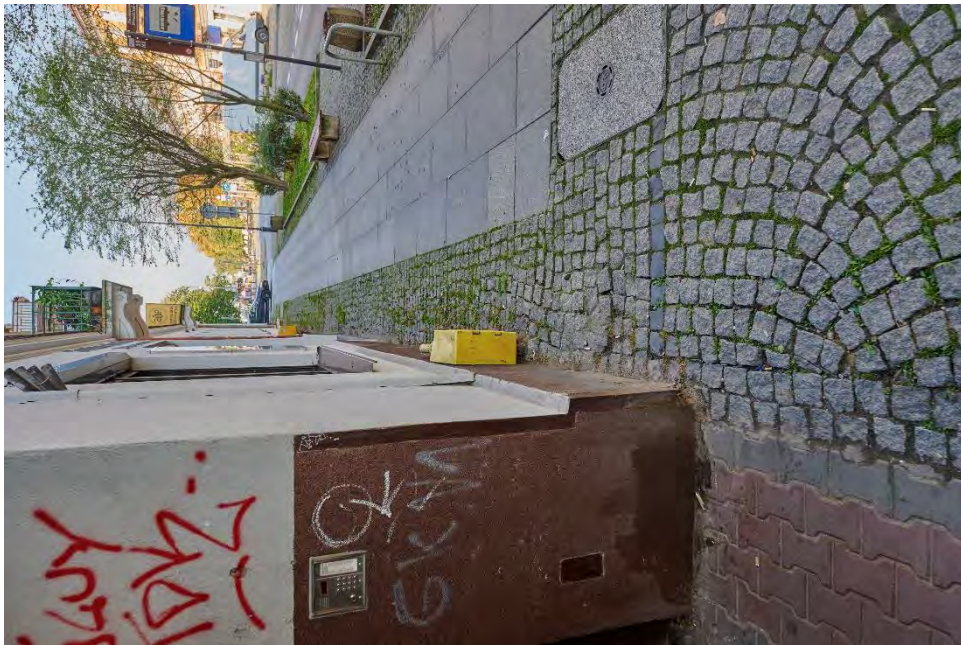
zdj.10 Brak odprowadzenia wody od budynku, zawilgocenia
