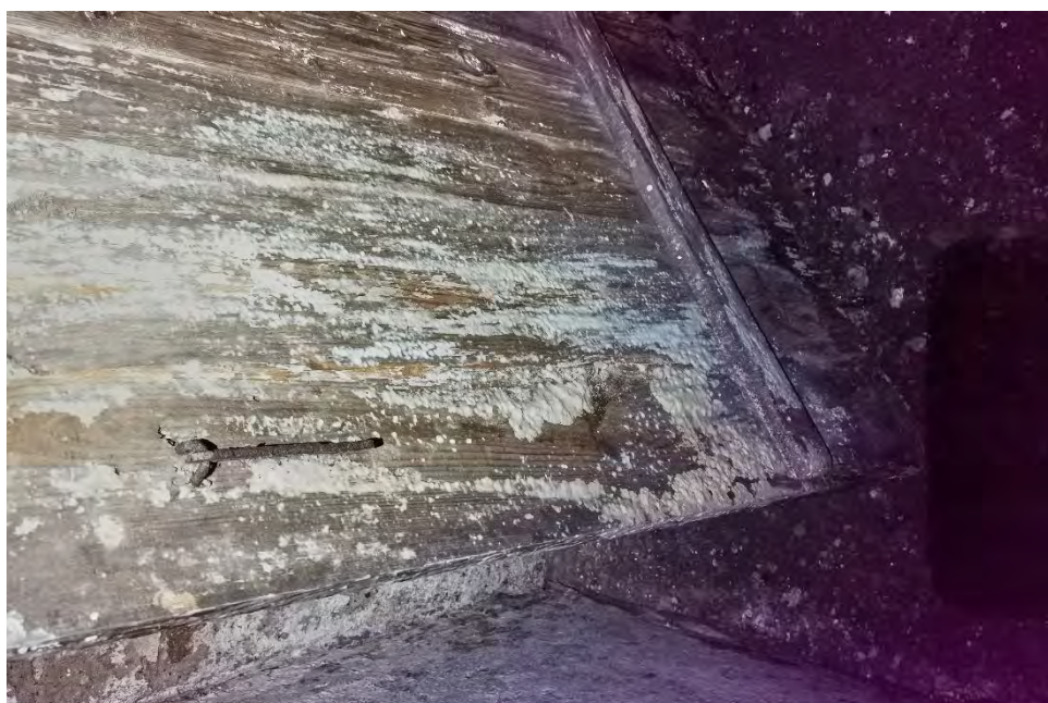
zdj.30 grzybnia grzyba domowego na drzwiach w piwnicy.
