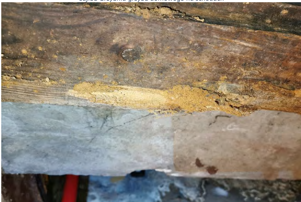
zdj.39 Korozja biologiczna stolarki drzwiowej piwnicy
