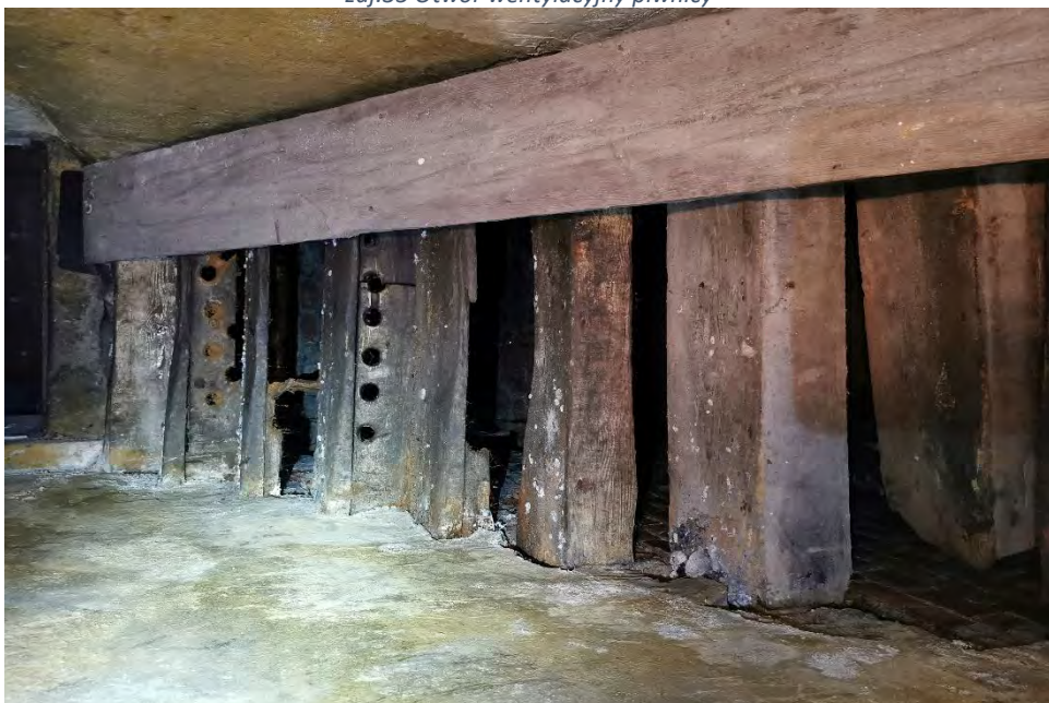
zdj.36 Porażone biologicznie i spożytkowane schody piwnicy
