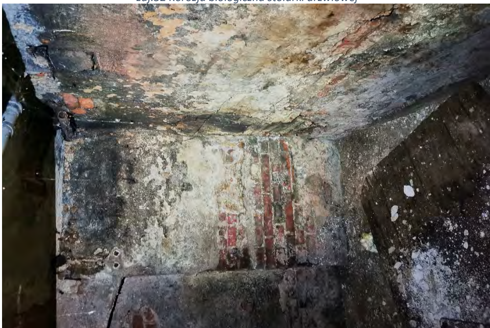
zdj.33 Kolonie grzybów pleśniowych na ścianach piwnicy, wysolenia i odspojenia tynków.
