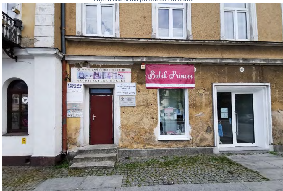
zdj.17 Fragment elewacji zachodniej- wysolenia i uszkodzenia tynków części przy cokołowej.
