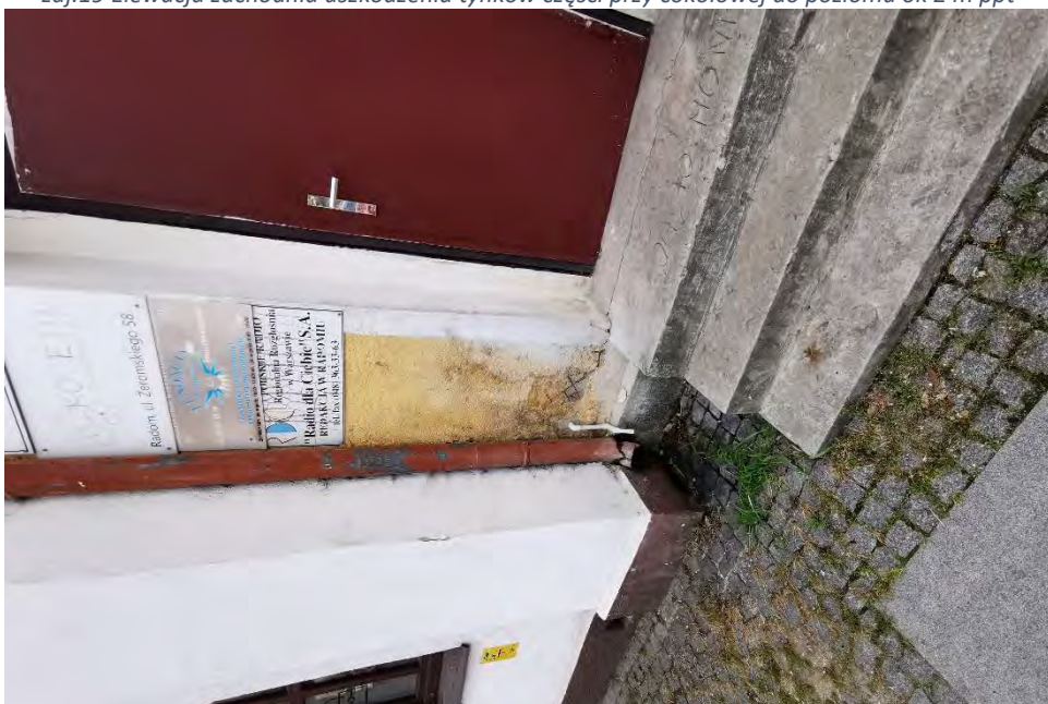
zdj.20 Brak odprowadzenia wody opadowej od budynku.
