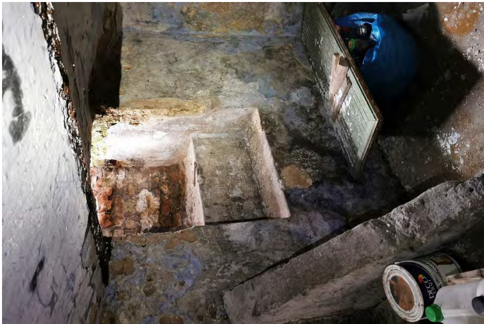
zdj.31 Zdegradowane tynki piwnicy
