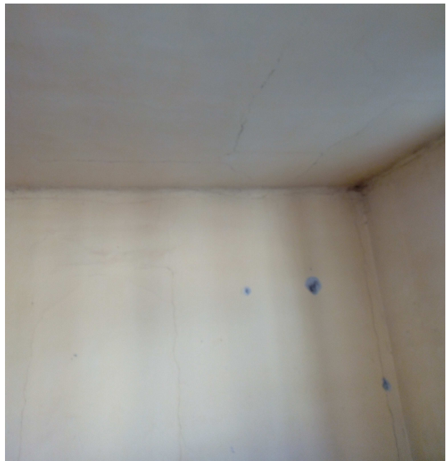
Fot. 6, 7 - rysy widoczne w ścianach konstrukcyjnych
