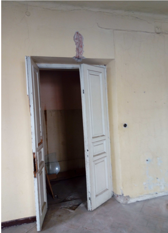
Fot. 6, 7 - rysy widoczne w ścianach konstrukcyjnych
